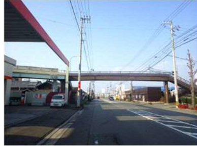
(喜田村横断歩道橋)
