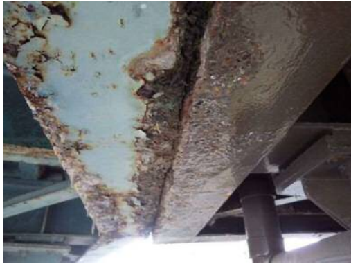
(主桁の腐食)
