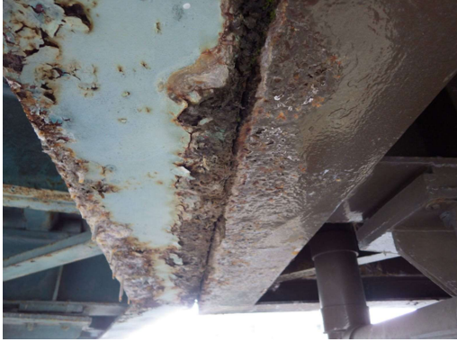
(主桁の腐食)
