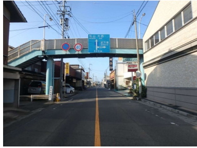
(波止浜横断歩道橋)
