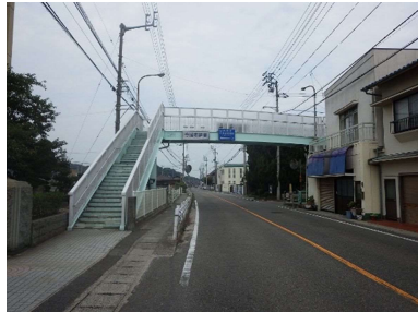
(延喜横断歩道橋)
