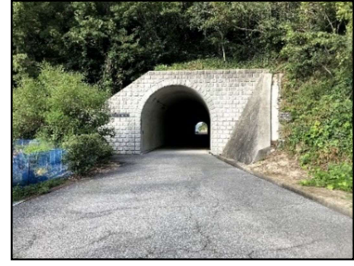
(馬島トンネル)
