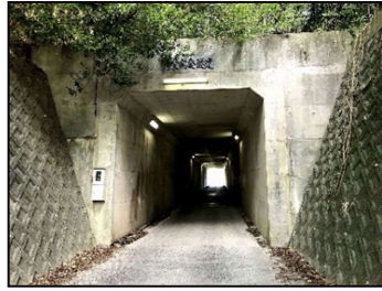
(産業開発隧道)
