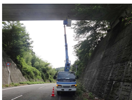
(高所作業車による点検)
