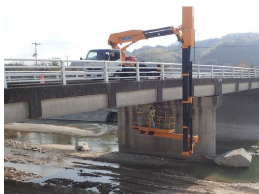
(点検車による点検)
