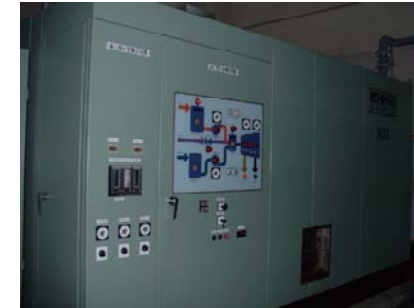
汚泥棟と遠心脱水機
