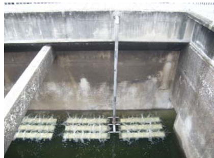
反応タンク散気盤
