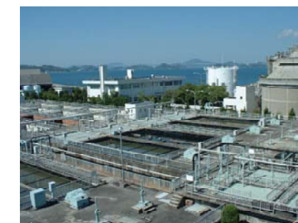
最初沈澱池と汚泥棟 (遠景)
