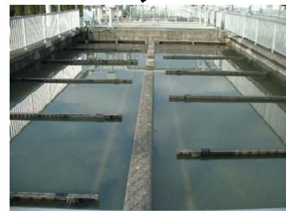
Tanque de sedimentación primaria
