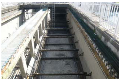
Tanque de sedimentación final, estructura interna
