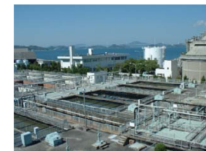
Vista lejano de las tanques de sedimentación primaria y edificio de tratamiento de lodos
