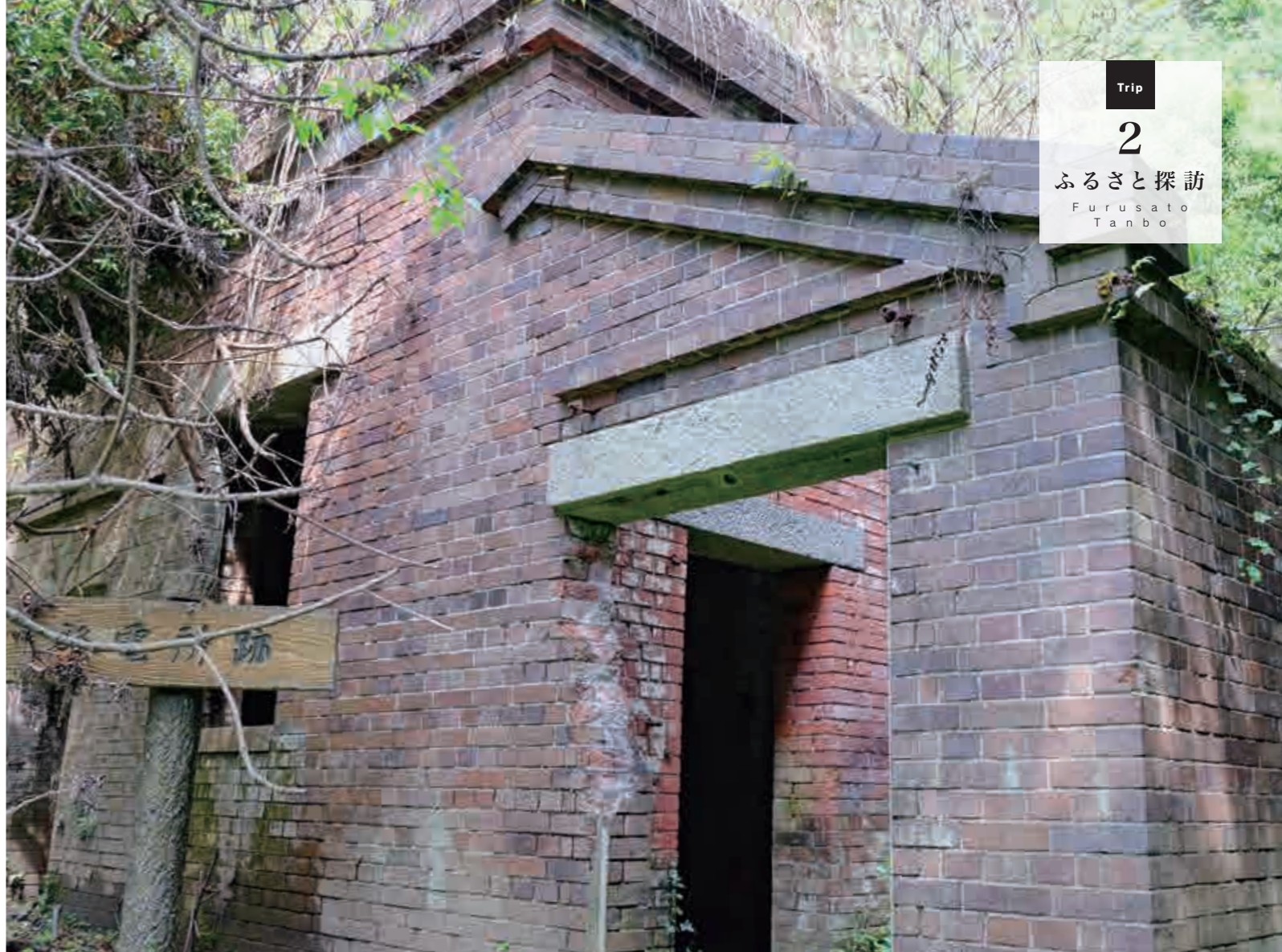
北部砲台跡の発電所跡
