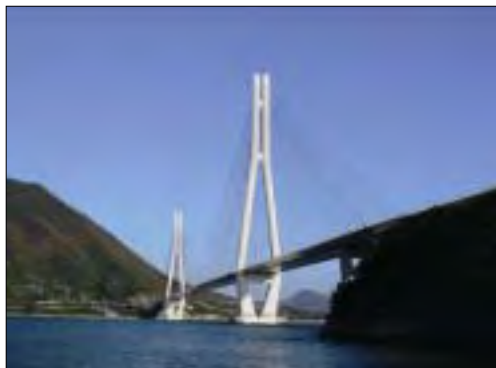
多々羅大橋
