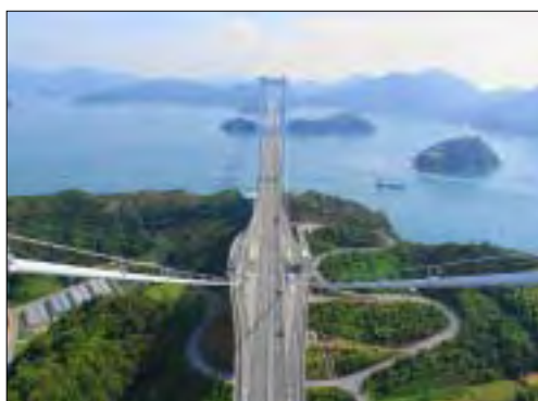
来島海峡大橋
