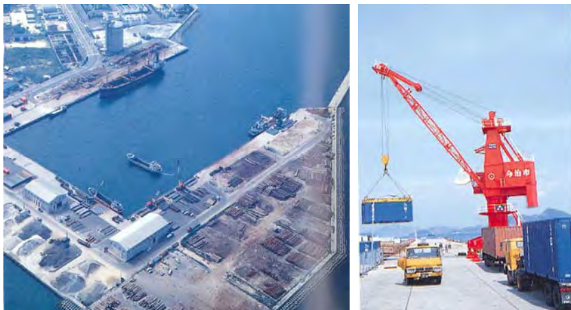
完成した貨物船用港（蔵敷地区）
