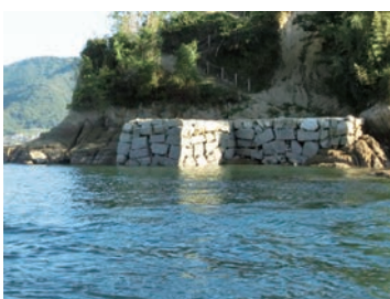
接岸施設（鯛崎島）
