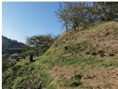
切岸及び天然の崖（通路状遺構を含む）
