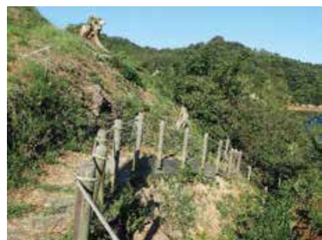
既設の手すり（郭Ⅳから東部海岸）
