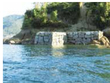
接岸施設（鯛崎島）
