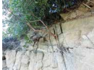
岩礁への樹根の浸食状況
