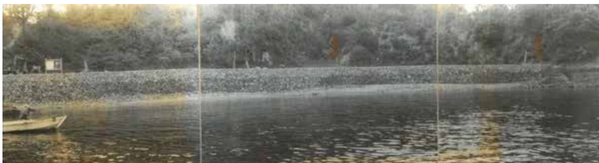
昭和 48～49 年の南部平坦地の石積復旧工事後
