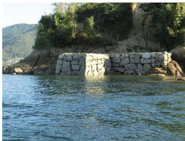
鯛崎島の接岸施設
