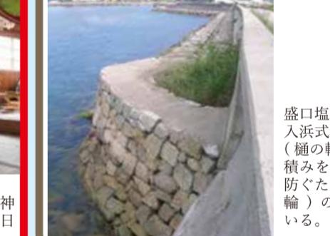
盛口塩田は、かつての盛口村(井口地区)にあった入浜式塩田で、嘉永3(1850)年に築造された。丸樋(樋の輪)は、堤防の外側に付属した馬蹄型の石構みをいい、波風や浮遊物の接触から樋の損傷を防ぐために築かれた。現在、残っている丸樋(樋の輪)の建築は明治・昭和初期であると考えられている。
