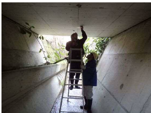
(脚立による点検)
