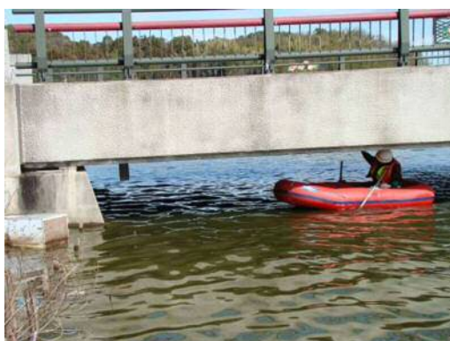
(ボートによる点検)
