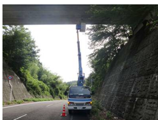
(高所作業車による点検)
