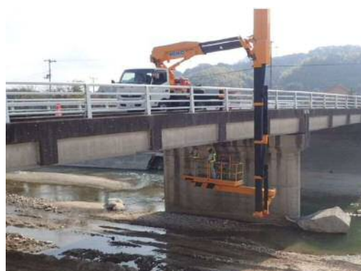
(点検車による点検)
