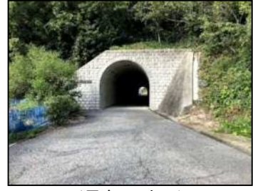
(馬島トンネル)
