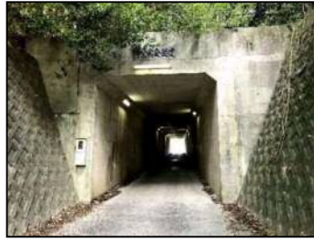
(産業開発隧道)
