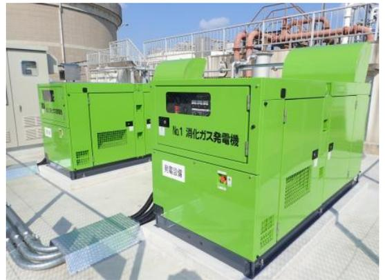
消化ガス発電機 60 k w × 2 台
