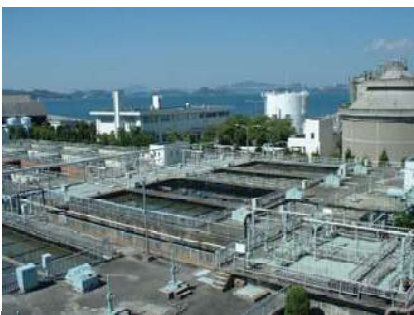
最初沈澱池と汚泥棟（遠景）
