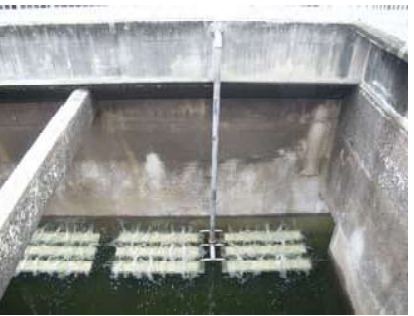
反応タンク散気盤
