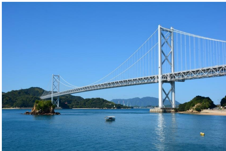
因島大橋(向島 ⇄ 因島、昭和 58 年 12 月完成)
