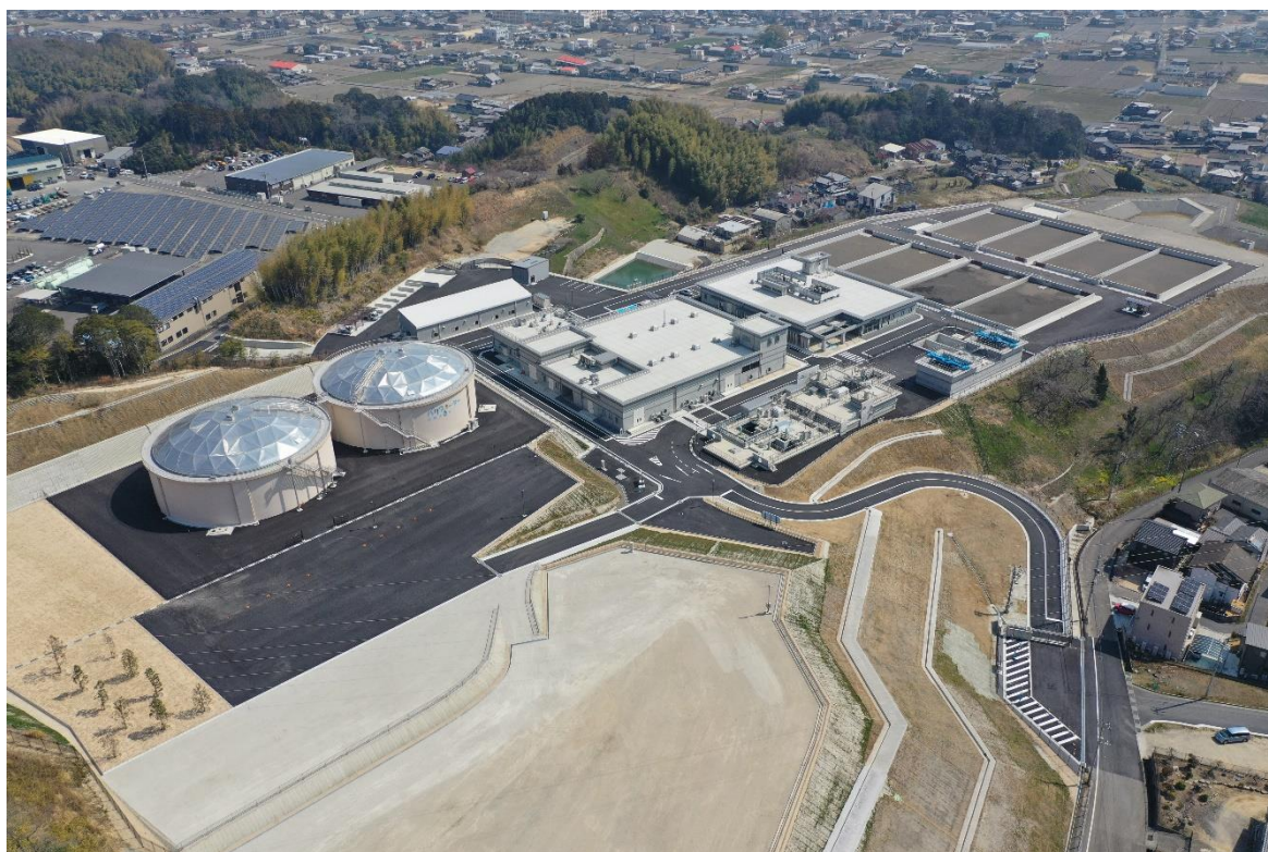
高橋浄水場（バリウォーター）
