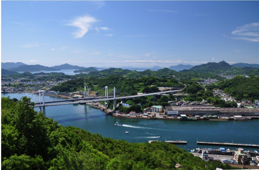
新尾道大橋(尾道 ⇄ 向島、平成 11 年 5 月完成)
