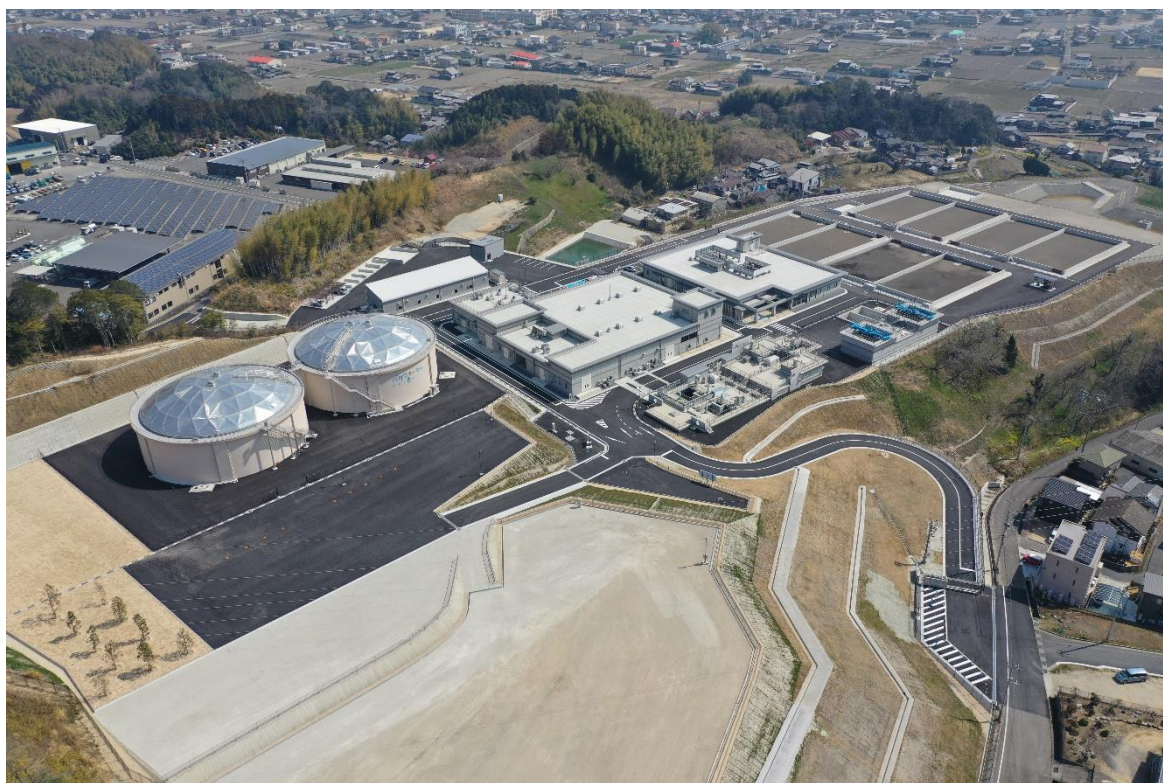
高橋浄水場（バリウォーター）
