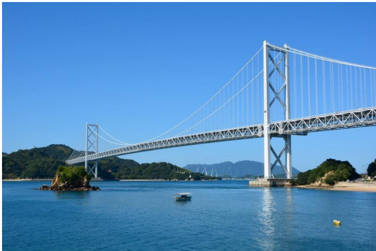
因島大橋(向島 ⇄ 因島、昭和 58 年 12 月完成)
