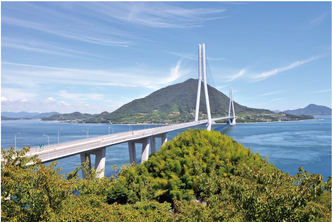
多々羅大橋(生口島 ⇄ 大三島、平成 11 年 5 月完成)
