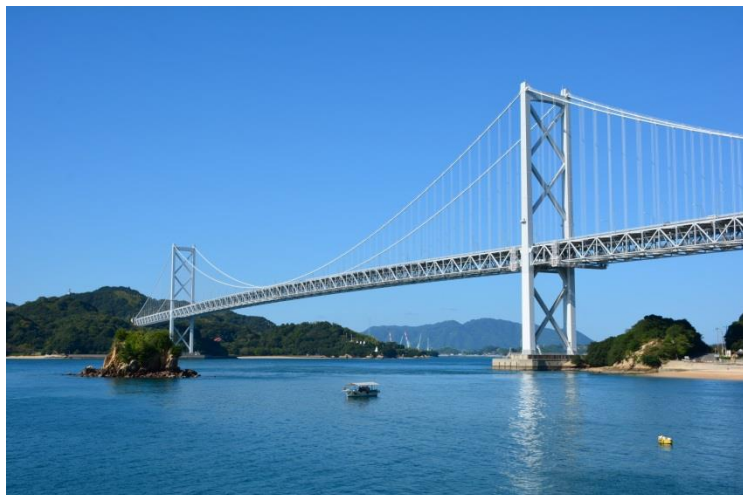
因島大橋(向島 ⇄ 因島、昭和 58 年 12 月完成)
