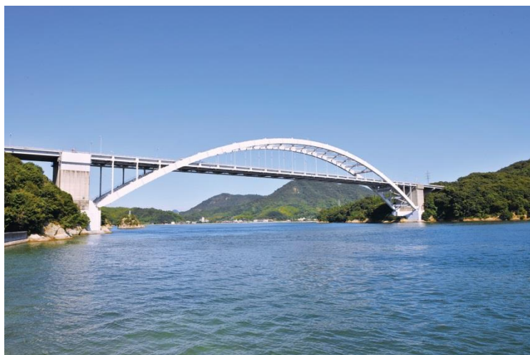
大三島橋(伯方島 ⇄ 大三島、昭和 54 年 5 月完成)
