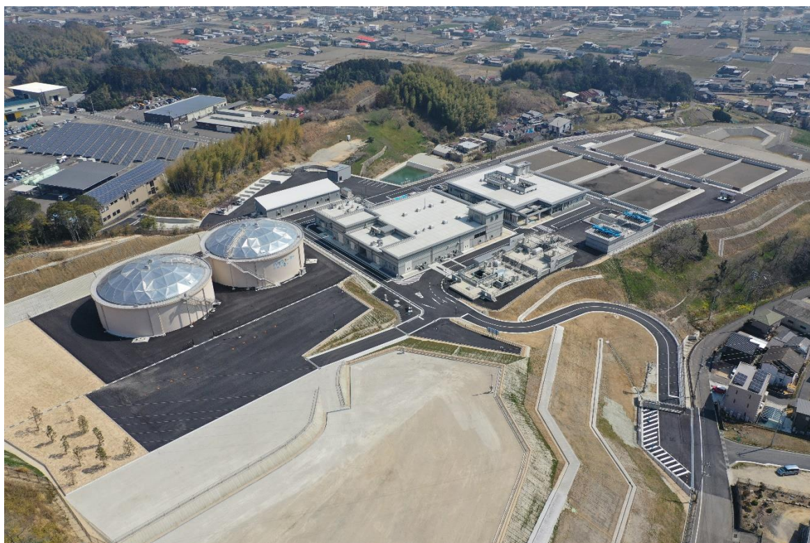
高橋浄水場（バリウォーター）
