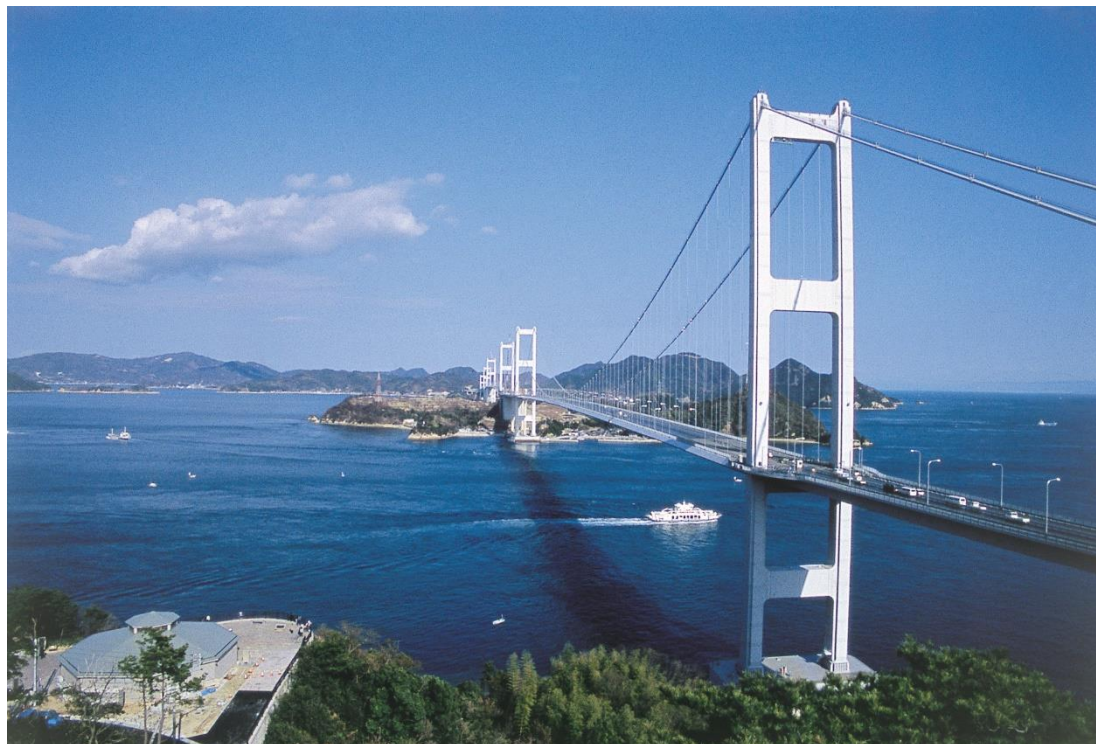
来島海峡大橋(大島 ⇄ 今治、平成 11 年 5 月完成)
