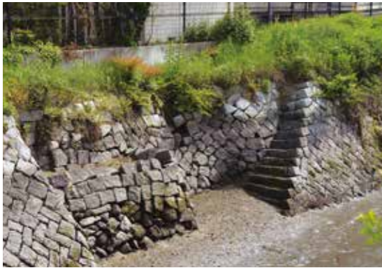
波止浜地区に残る古い雁木
