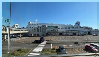
旅客船が接岸可能な岸壁整備
