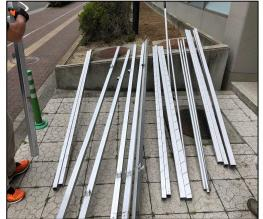
ネットを固定するための支柱です。 市役所前は風が強いため、ステンレス 製の頑丈なものを使用しています。
