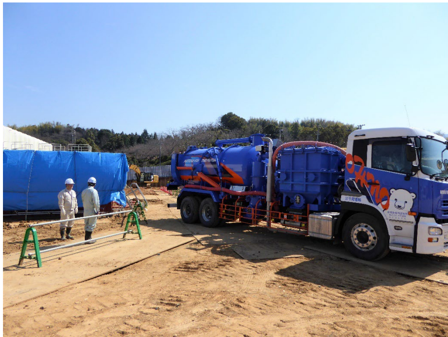
写真 6.5-2 埋設廃棄物等対策工事における汚水の搬出状況
