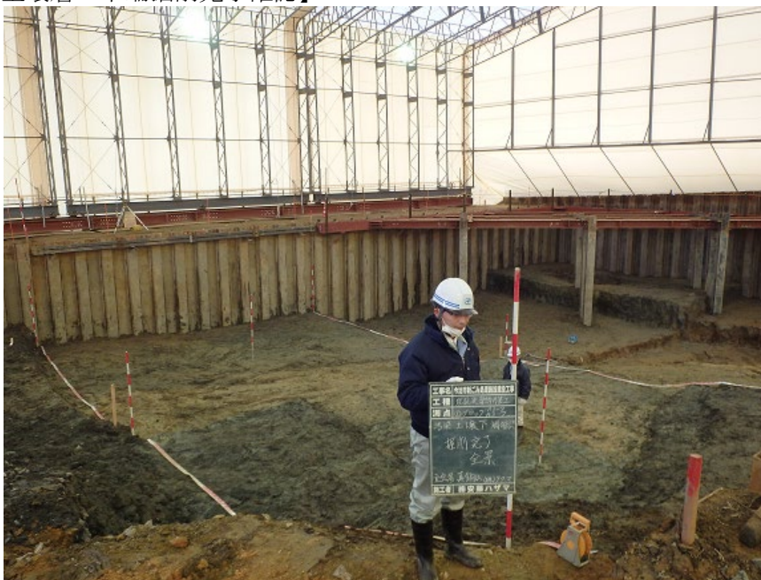
写真 6.7-2(3) 埋設廃棄物対策等工事の現況検分状況 (B-3-7 区画)
