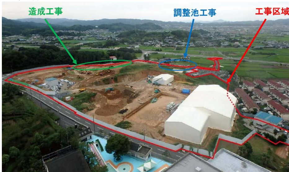
写真 2.6-1(3) 工事の進捗状況
