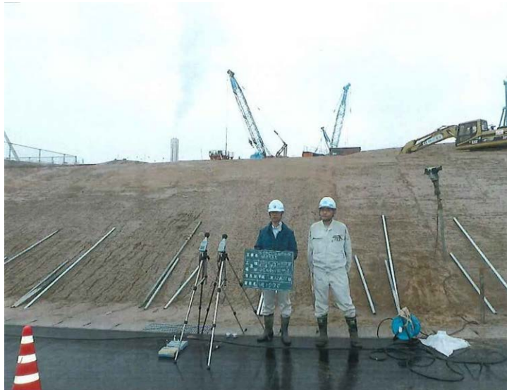
写真 6.2-1(2) 騒音・振動の調査状況
