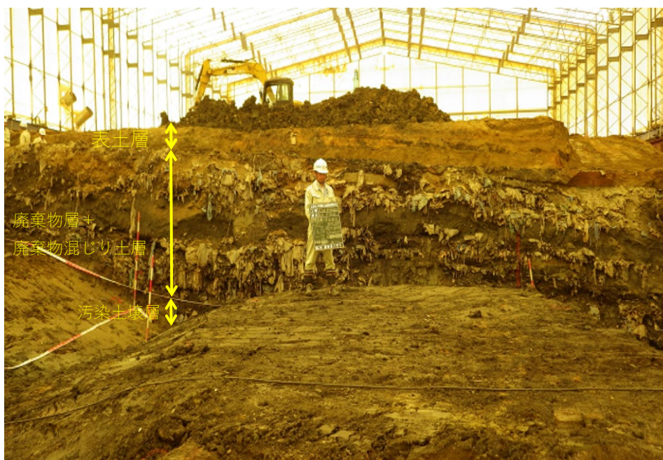
写真 2.6-2 埋設廃棄物対策等工事区域内の土層の堆積状況
