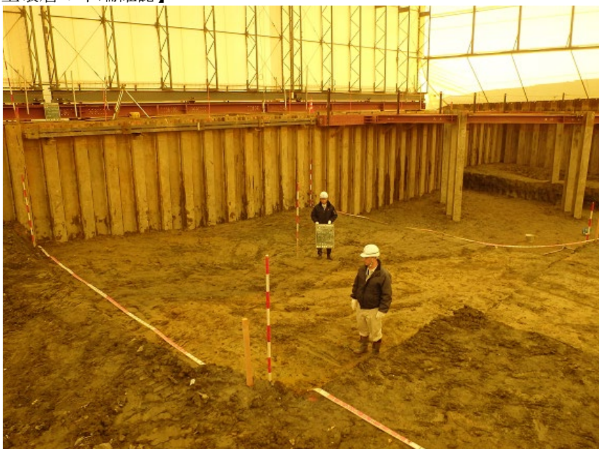
写真 6.7-2(2) 埋設廃棄物対策等工事の現況検分状況 (B-3-7 区画)
