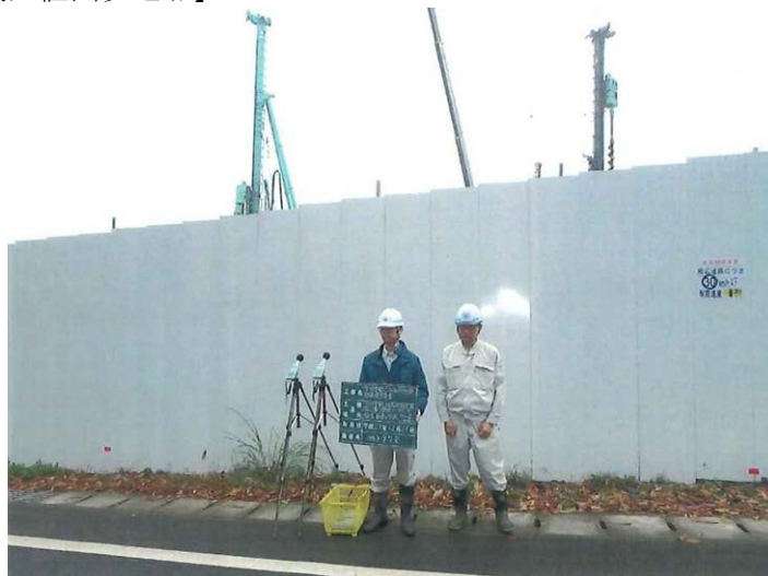
写真 6.2-1(1) 騒音・振動の調査状況
