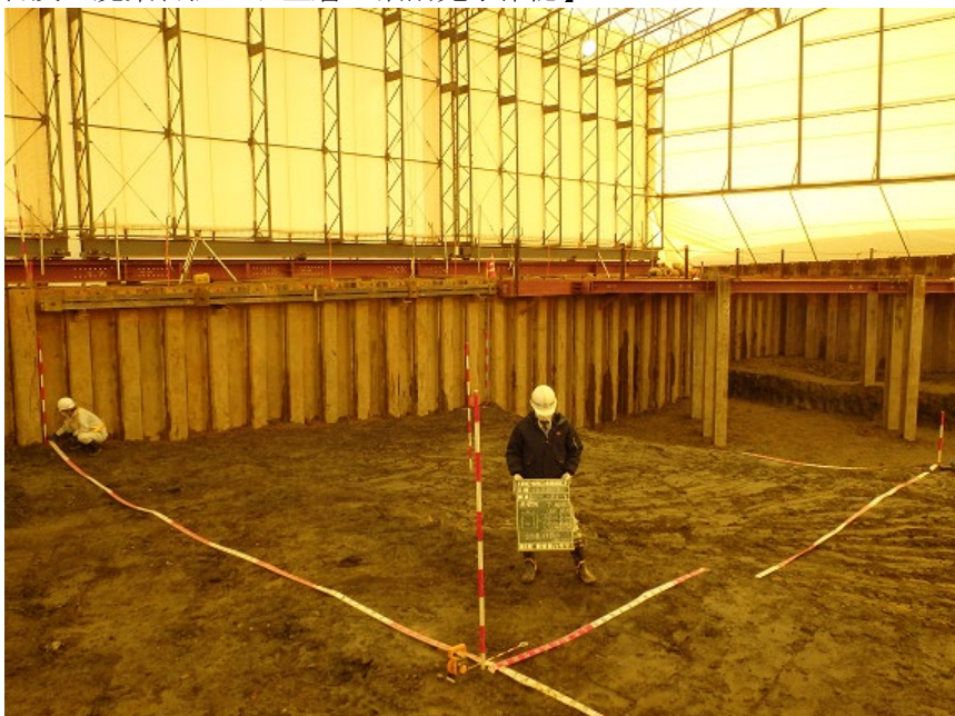
【廃棄物及び廃棄物混じり土層の掘削完了確認】
