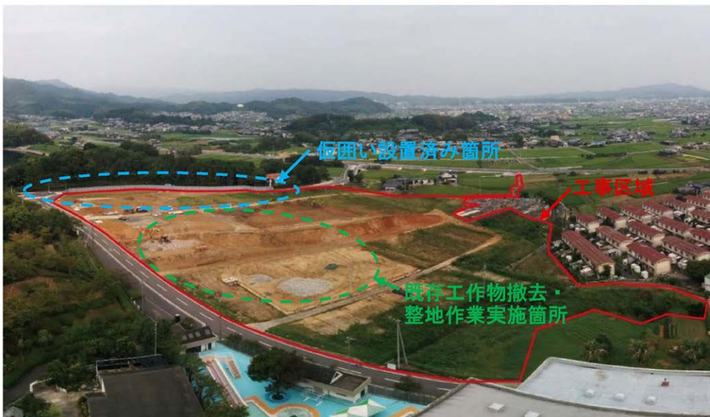
写真 2.6-1(1) 工事の進捗状況
