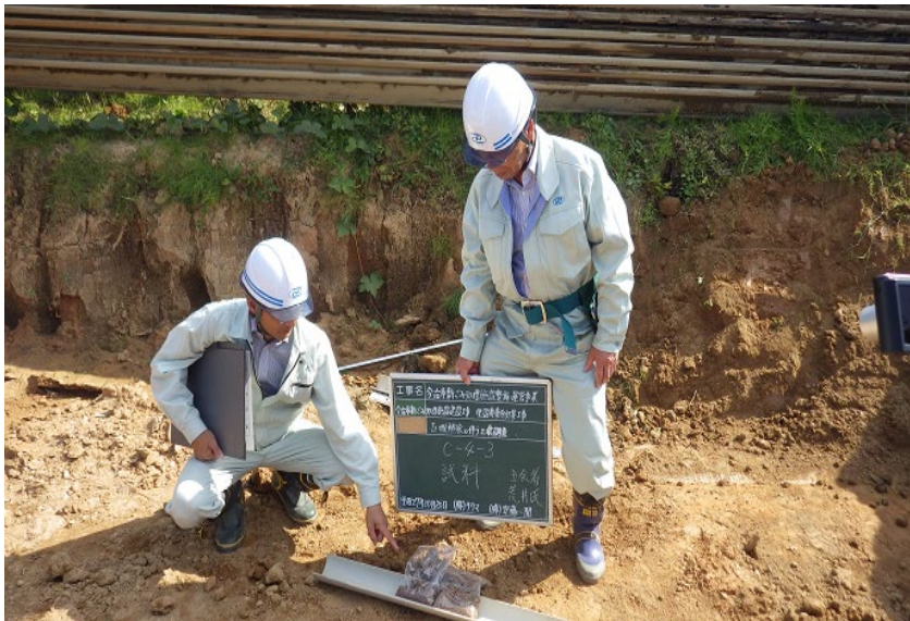
写真 6.7-3 埋め戻し完了後の地下水及び表層土壌調査状況
