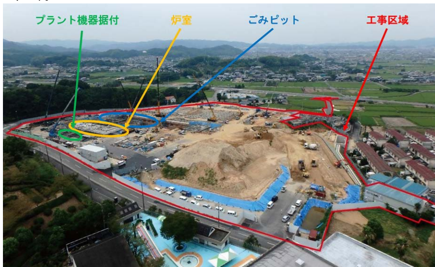
写真 2.6-1(5) 工事の進捗状況
