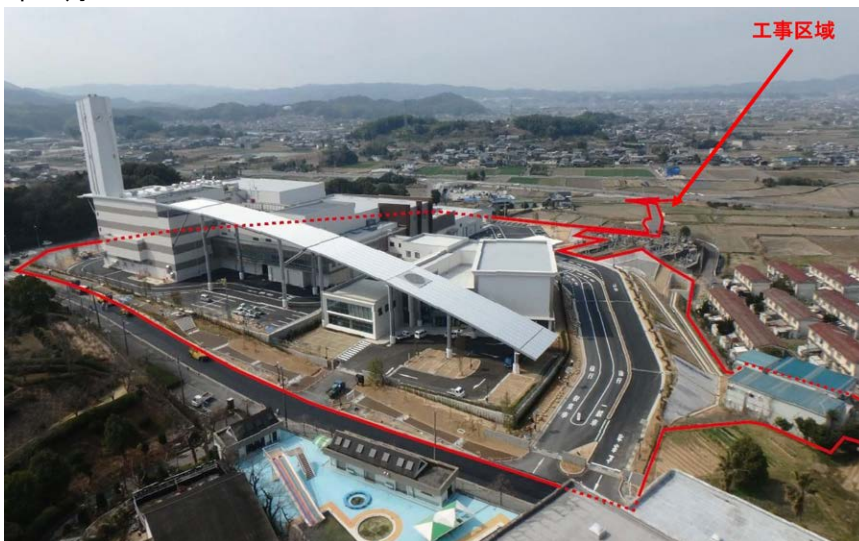
写真 2.6-1(8) 工事の進捗状況
