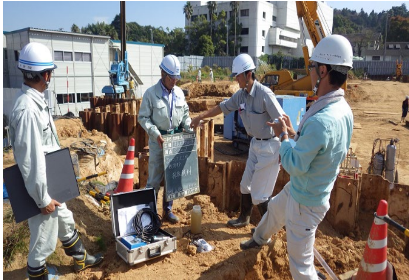
【工事区域直下の観測井戸採水状況】
