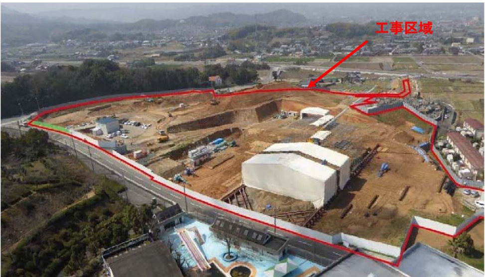
写真 2.6-1(2) 工事の進捗状況
