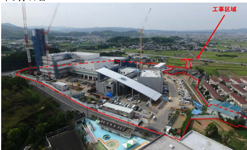
写真 2.6-1(7) 工事の進捗状況
