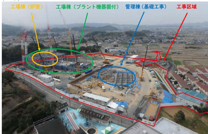
写真 2.6-1(6) 工事の進捗状況
