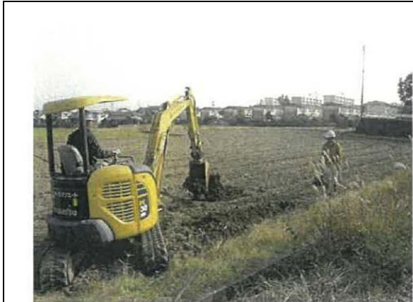
トレンチ掘削
