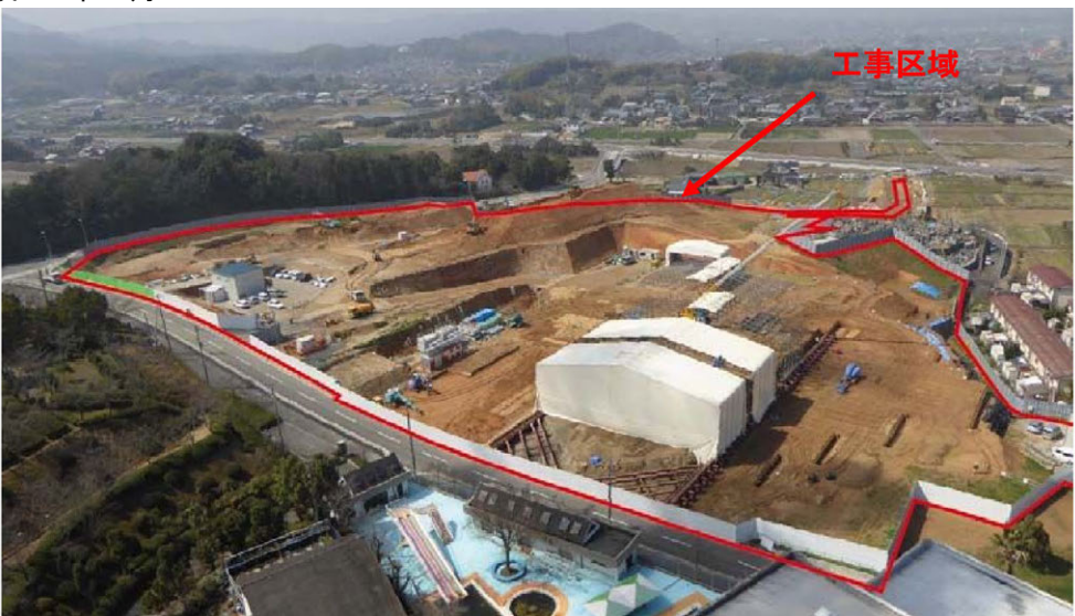
写真 2.6-1(2) 工事の進捗状況
