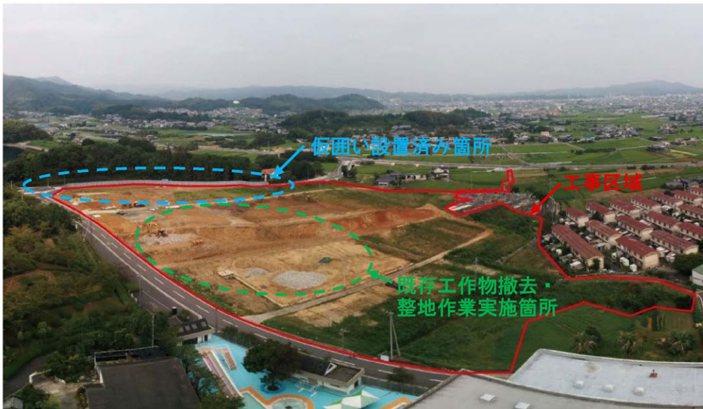
写真 2.6-1(1) 工事の進捗状況
