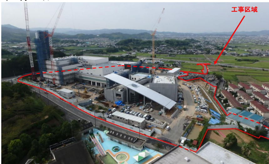
写真 2.6-1(7) 工事の進捗状況
