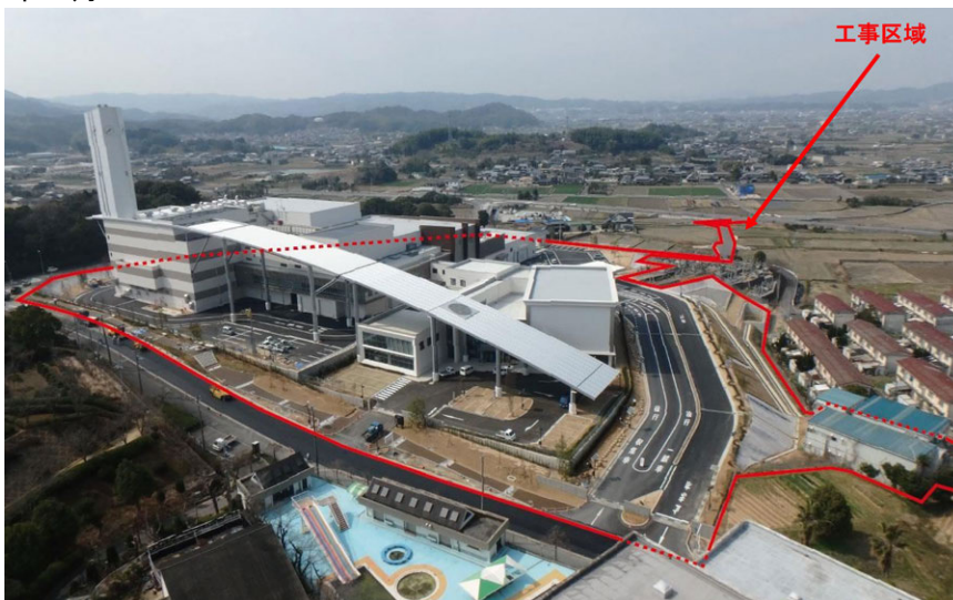
写真 2.6-1(8) 工事の進捗状況
