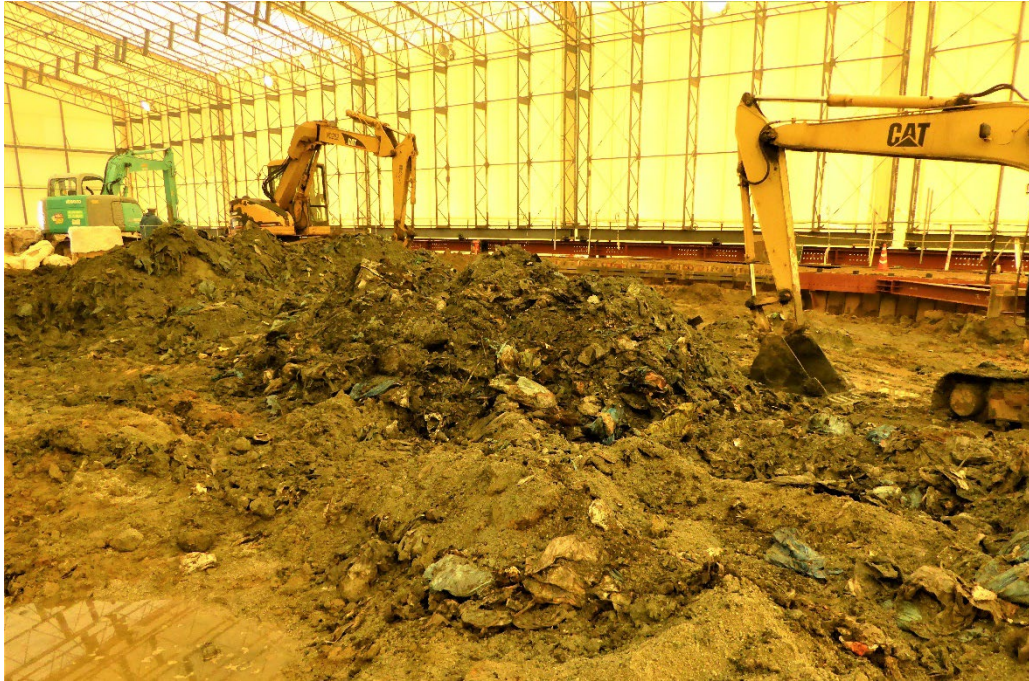
写真 6.10-1 埋設廃棄物対策等工事の実施状況
