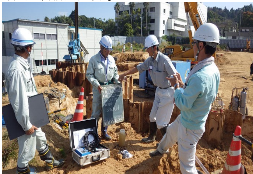
【工事区域直下の観測井戸採水状況】
