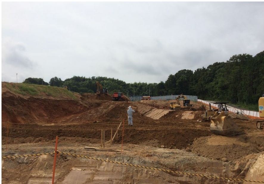
写真 6.10-3 造成工事の状況
