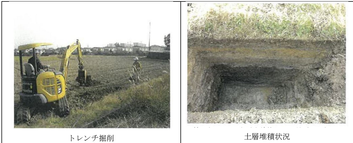
写真 6.9-1 試掘状況（平成 25 年 12 月実施）
