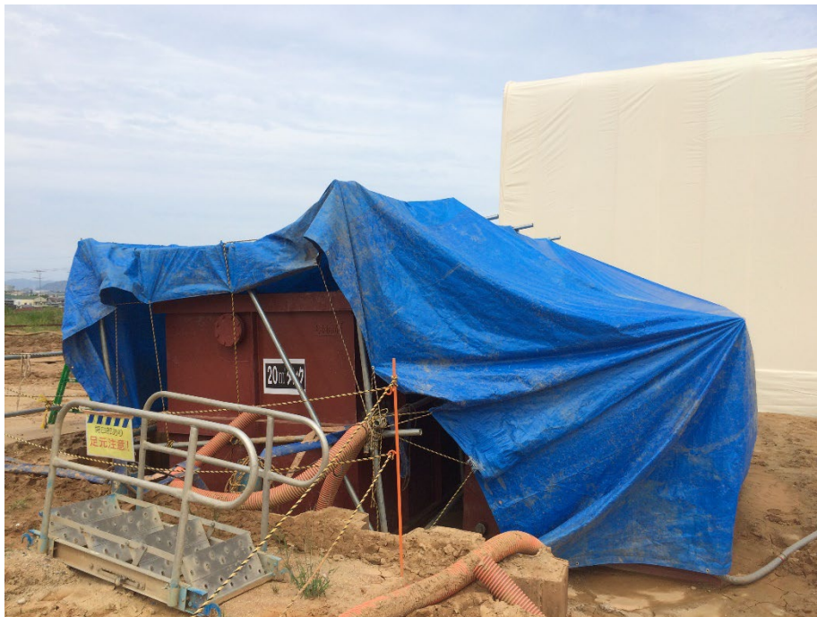
写真 6. 5-1 埋設廃棄物対策等工事における汚水の一時的貯留
