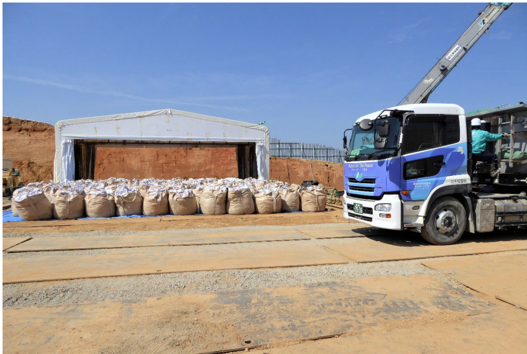
写真 6.10-2 埋設廃棄物対策等工事における廃棄物の搬出状況
