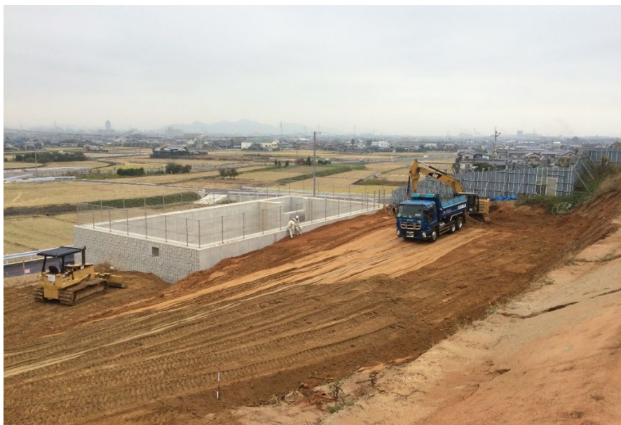
写真 6.10-4 造成工事の状況（場内発生土による埋め戻し）
