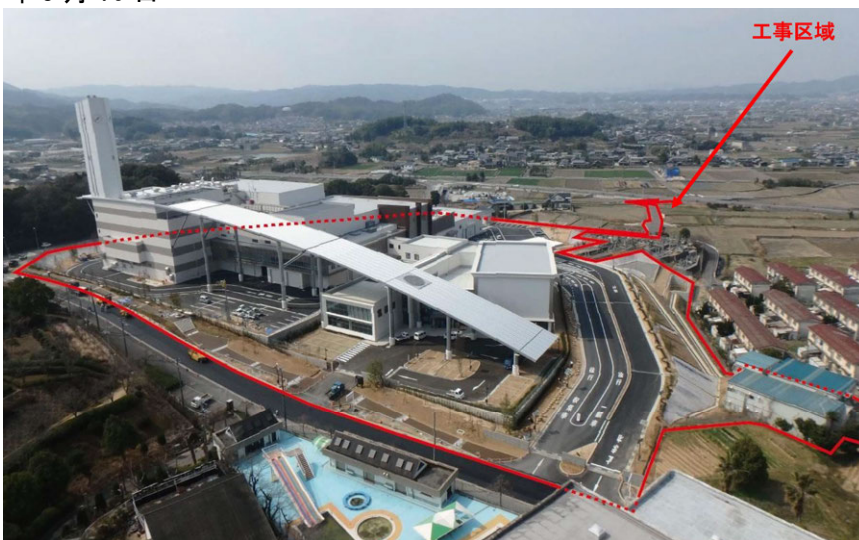
写真 2. 6-1 (8) 工事の進捗状況
