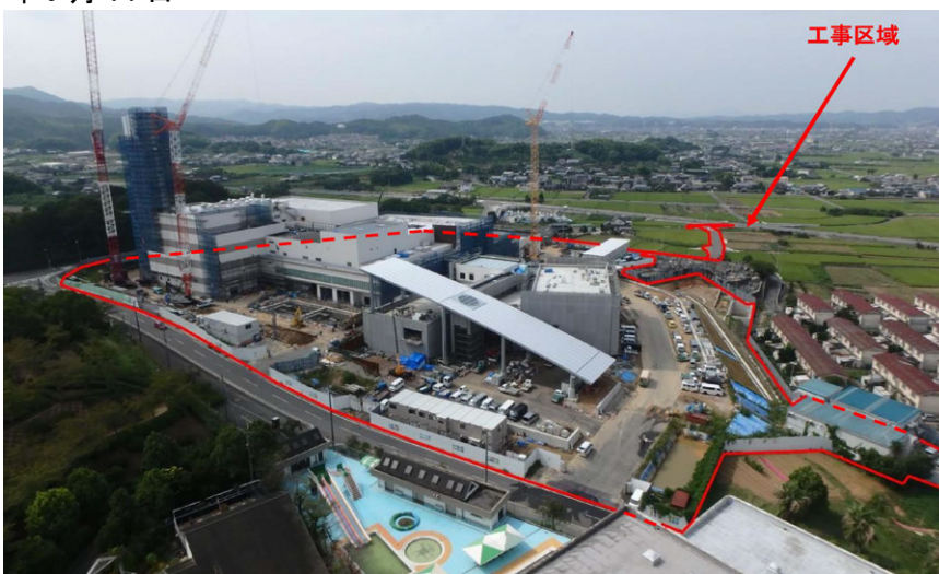
写真 2.6-1(7) 工事の進捗状況
