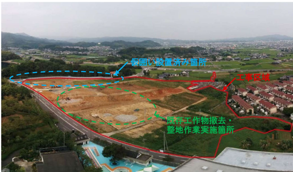
写真 2.6-1(1) 工事の進捗状況
