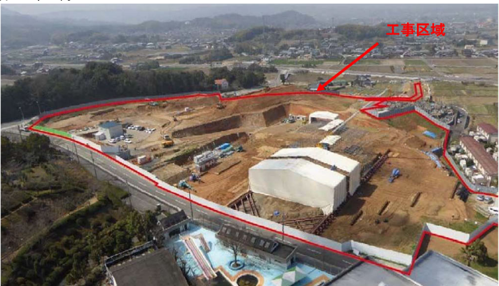
写真 2.6-1(2) 工事の進捗状況
