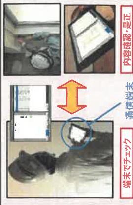
通信端末で内装仕上げの確認・是正
