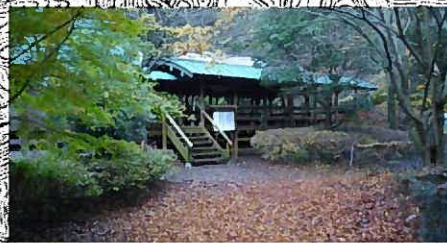
②鉱泉受湯槽
