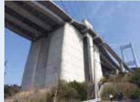
馬島のエレベーター部 の大きな橋脚
