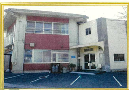
正面玄関・駐車場
