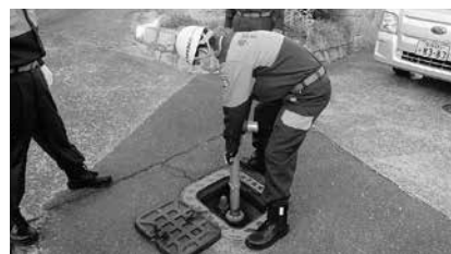
消火栓の点検
