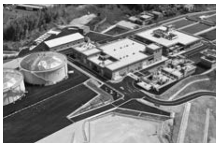
3月に稼働を開始した「バリウォーター」
