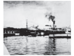
完成した港内と第一棧橋
