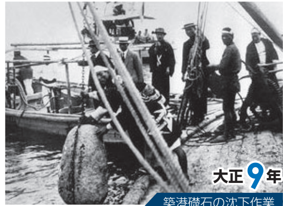
築港礎石の沈下作業
