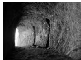
大浜地区で確認された防空壕
