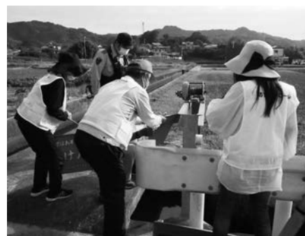
「きけん」旗の確認・設置
