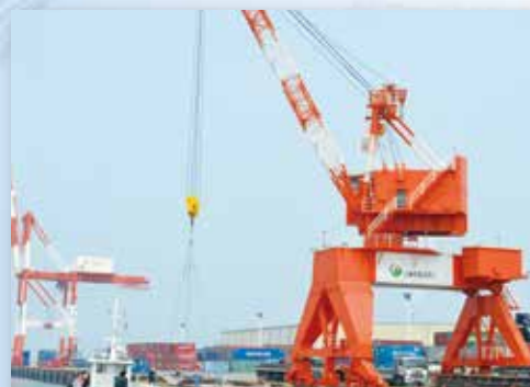
H23年8月設置 Installed in August 2011
