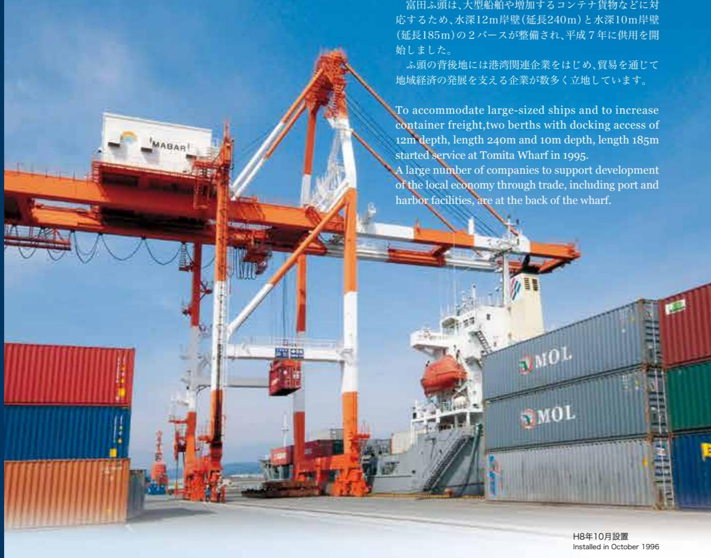
富田ふ頭は、大型船舶や増加するコンテナ貨物などに対応するため、水深12m岸壁(延長240m)と水深10m岸壁(延長185m)の2バースが整備され、平成7年に供用を開始しました。
