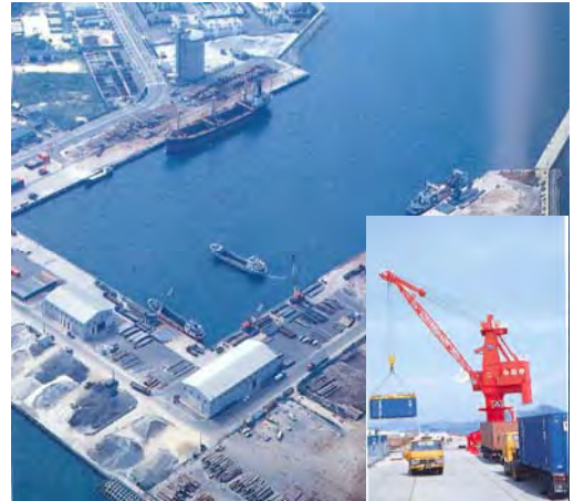
完成した貨物船用港（蔵敷地区）
