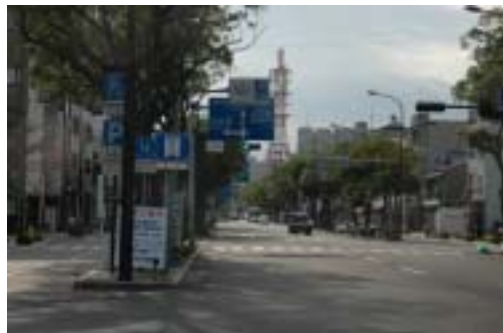
主要地方道今治港線（広小路）
