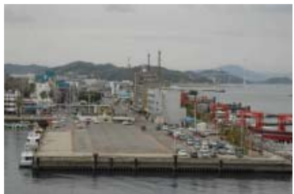
現在の今治港内港（沖洲外から）
