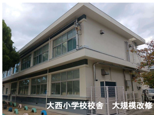
大西小学校校舎 大規模改修
