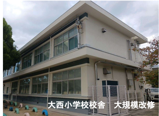
大西小学校校舎 大規模改修
