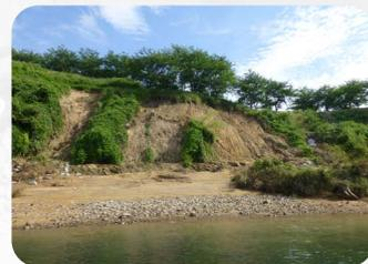
船だまり南側斜面の崩落はすぐ上の二之丸縁辺にもおよび、郭（くるわ）（城の平坦な面）を形作っていた盛土の一部が流出してしまったのです。総雨量400mmを超える豪雨は、能島城跡のみならず、周辺の大島や伯方島の至るところでも大規模な土砂災害を引き起こしました。
