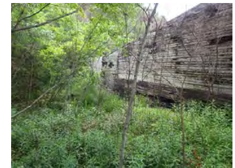
砂防ダム2(平成24年8月完成) 上流側
