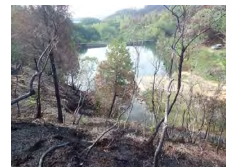
谷止工23 上流側状況
