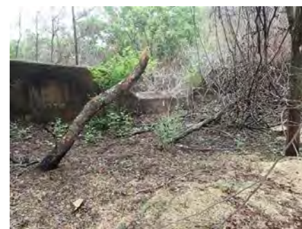
谷止工3(平成11年施工) 堆砂状況
