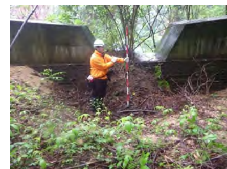
谷止工5(平成20年施工) 堆砂状況
