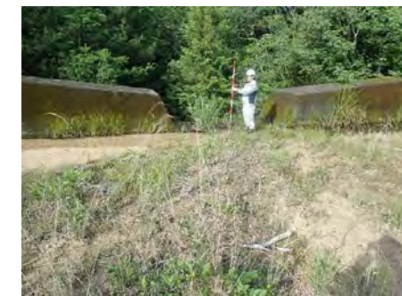
谷止工22(昭和62年施工) 堆砂状況(概ね満砂)
