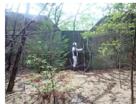
谷止工17(平成11年施工) 堆砂状況
