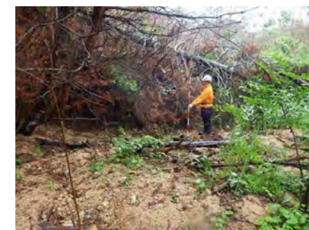
谷止工4(1)(平成11年施工) 堆砂状況(満砂)
