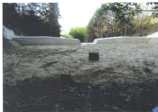
完成時（ダムの高さまで満砂しているタイプ） 平成20年施工（上流側）
