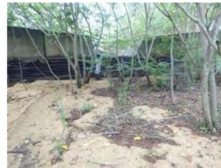
谷止工14(平成20年施工) 堆砂状況
