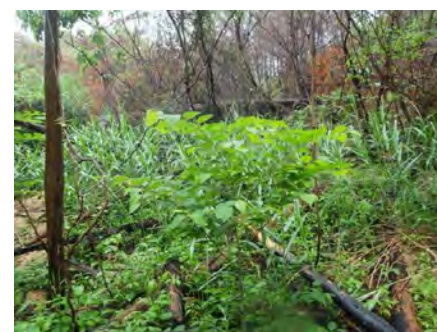
谷止工4(2)(平成11年施工) 堆砂状況(満砂)
