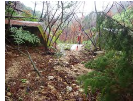
谷止工7(平成20年施工) 堆砂状況(満砂)
