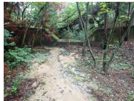
谷止工1(平成10年施工) 概ね満砂状況
