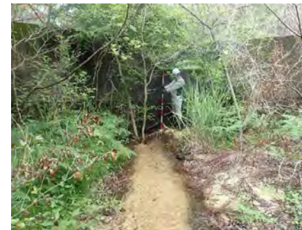
谷止工16(1)(平成10年施工) 堆砂状況
