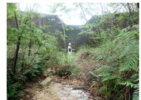
谷止工18(平成12年施工) 堆砂状況
