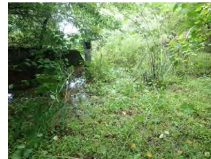
谷止工12(1)(平成20年施工) 堆砂状況(満砂)
