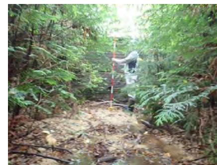
谷止工13(1)(平成20年施工) 堆砂状況
