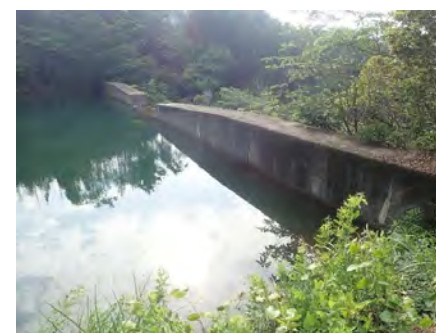
谷止工23 上流側状況
