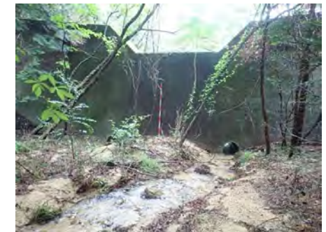
谷止工15(平成10年施工) 堆砂状況
