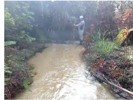
谷止工24(昭和63年施工) 堆砂状況(満砂)
