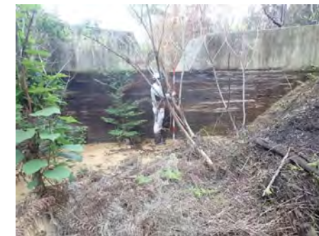
谷止工20(平成24年施工) 堆砂状況
