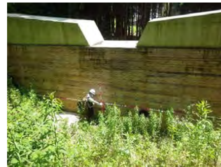
谷止工11(1)(令和4年施工) 堆砂状況
