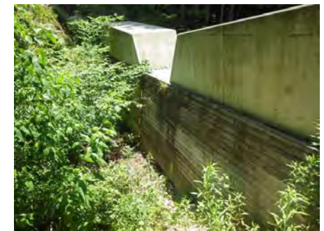
谷止工10(令和3年施工) 堆砂状況
