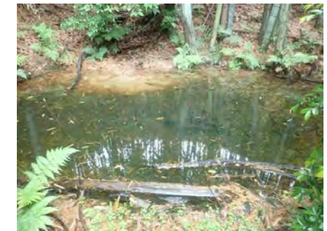
谷止工12(1)(平成20年施工) 湛水状況(灰の流下)
