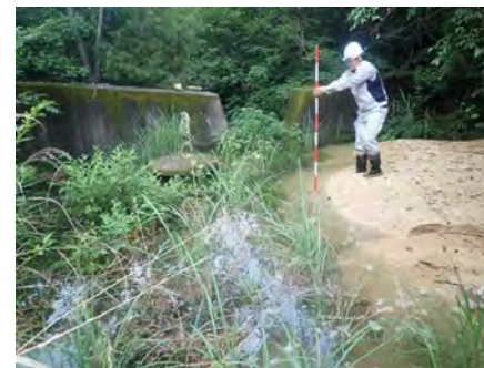
谷止工19(平成4年施工) 堆砂状況(概ね満砂)
