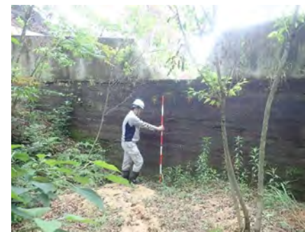
谷止工21(平成24年施工) 堆砂状況
