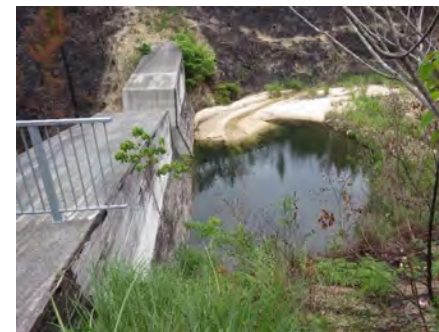
砂防ダム1(平成29年3月完成) 上流側
