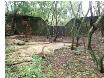
谷止工2(平成11年施工) 堆砂状況
