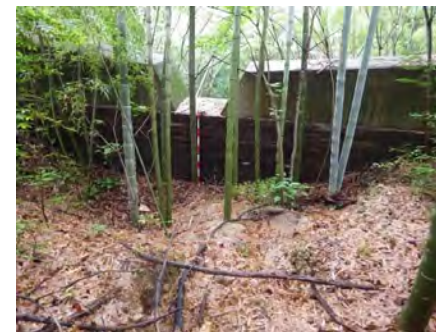
谷止工9(平成27年施工) 堆砂状況
