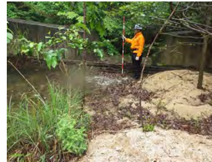
谷止工6(1)(平成20年施工) 堆砂状況
