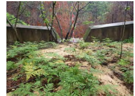
谷止工8(平成20年施工) 堆砂状況(満砂)
