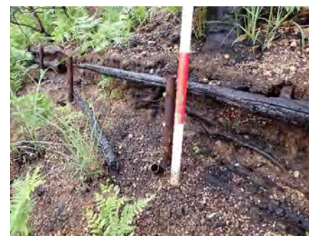
笠松山 筋工焼損状況
