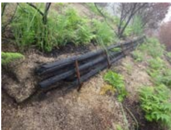
写真 3.1 柵工（鋼柱柵）
