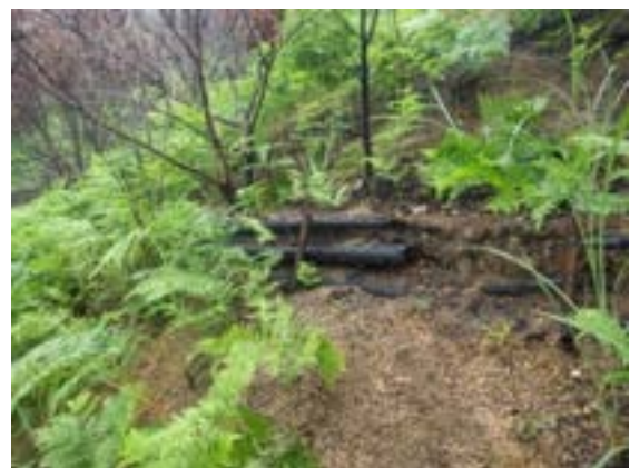
写真 3.1 柵工（鋼柱柵）
