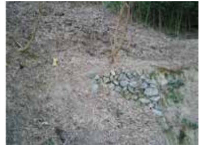
船だまり斜面の石積遺構
