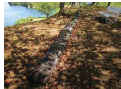
郭I北側の植生土のうによる 法肩への雨水流入対策
