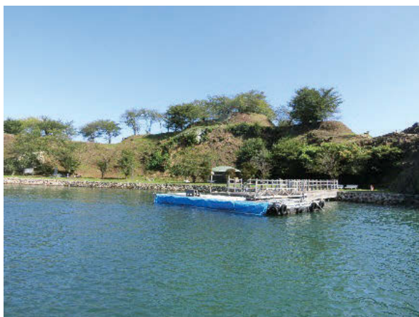
能島の接岸施設
