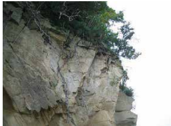
平成18(2006)年の鯛崎島の岩礁剥離の様子
