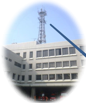
消防本部無線基地局
