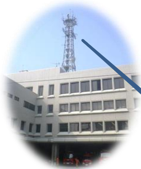
消防本部無線基地局
